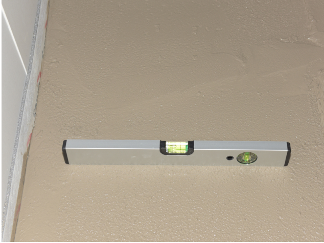
Gefälle mit Neigung zum Abfluss.
