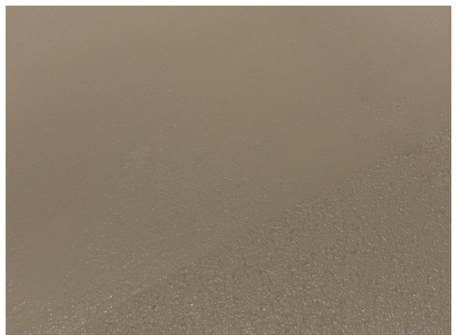
Somit werden Kellenschläge und Lunker vermieden.
