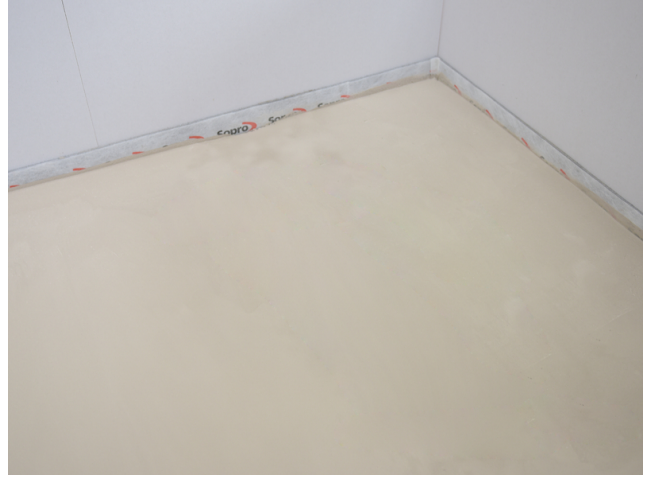
Sopro VS 582 im getrockneten Zustand.
