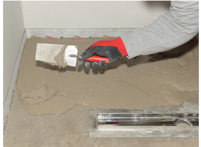
Herstellung eines Gefällespachtels durch Ausbreiten mit der Kelle auf der Fläche. Einbauen eines Gefälles bis max. 4 % möglich.
