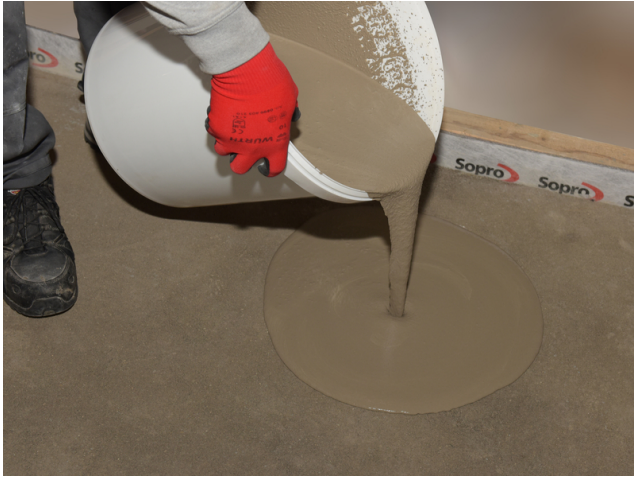
Ausgießen des VS 582 in Fließspachtelkonsistenz bei max. Wasserzugabe (5,25 l).
